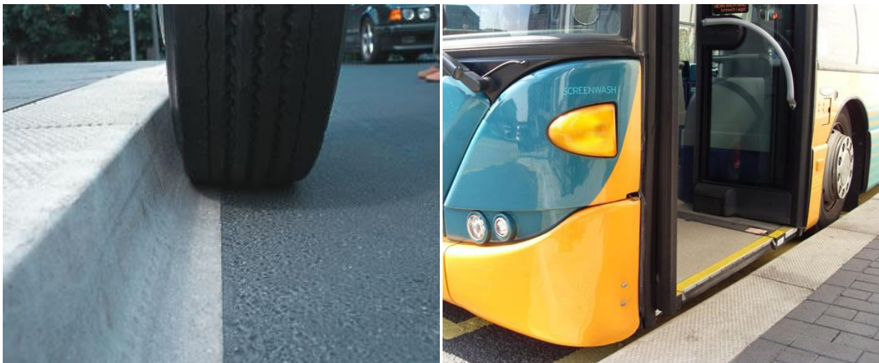
Fig. 15 - Cordolo profilato tipo "Kassel Kerb" diffusamente utilizzato in Germania, Paesi Bassi e Belgio
