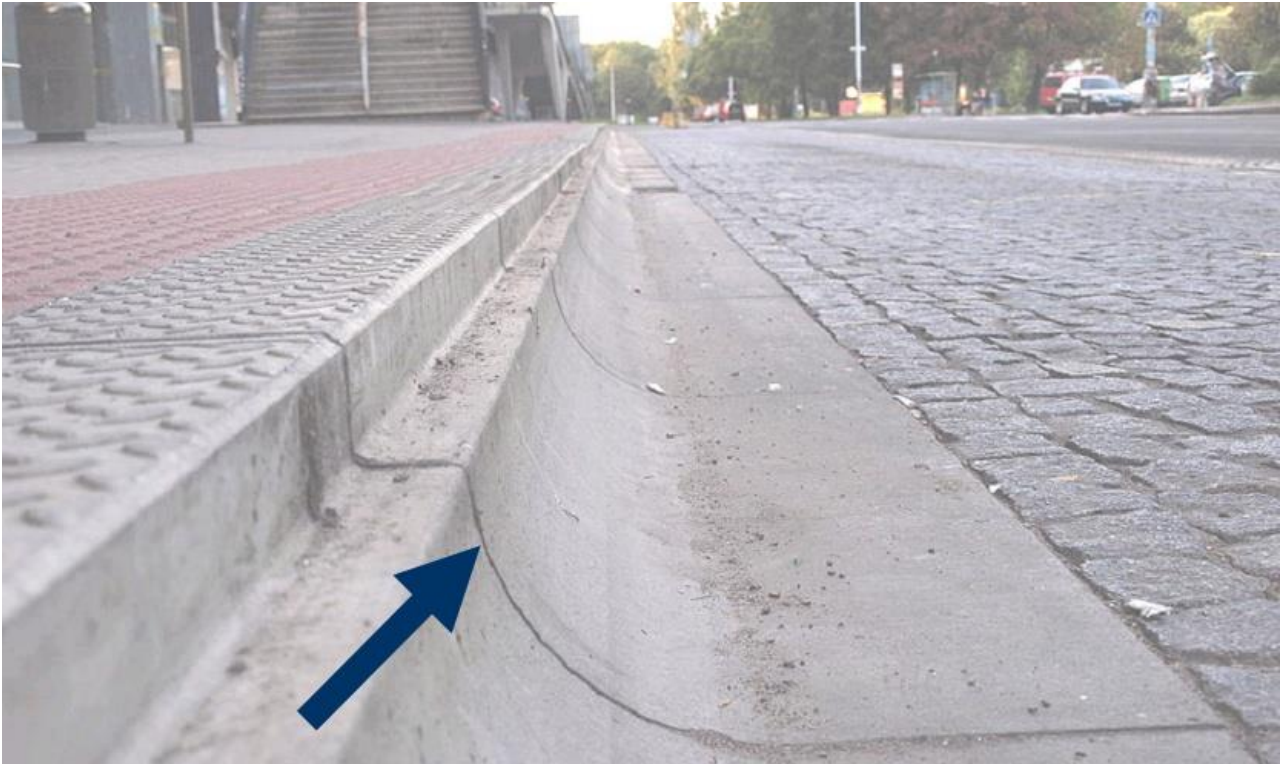
Fig. 14 - São Paulo (Brasile) linea BRT, bordino del cordolo di fermata ad invito
