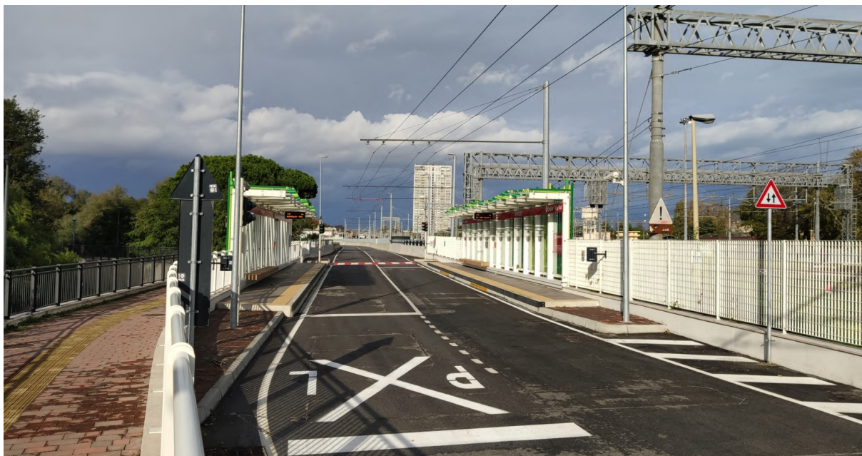
Fig. 5 | Vista dell'impianto sulla tratta a doppia via di corsa presso la fermata Kennedy e il passaggio a livello del binario per le Officine Grandi Riparazioni
