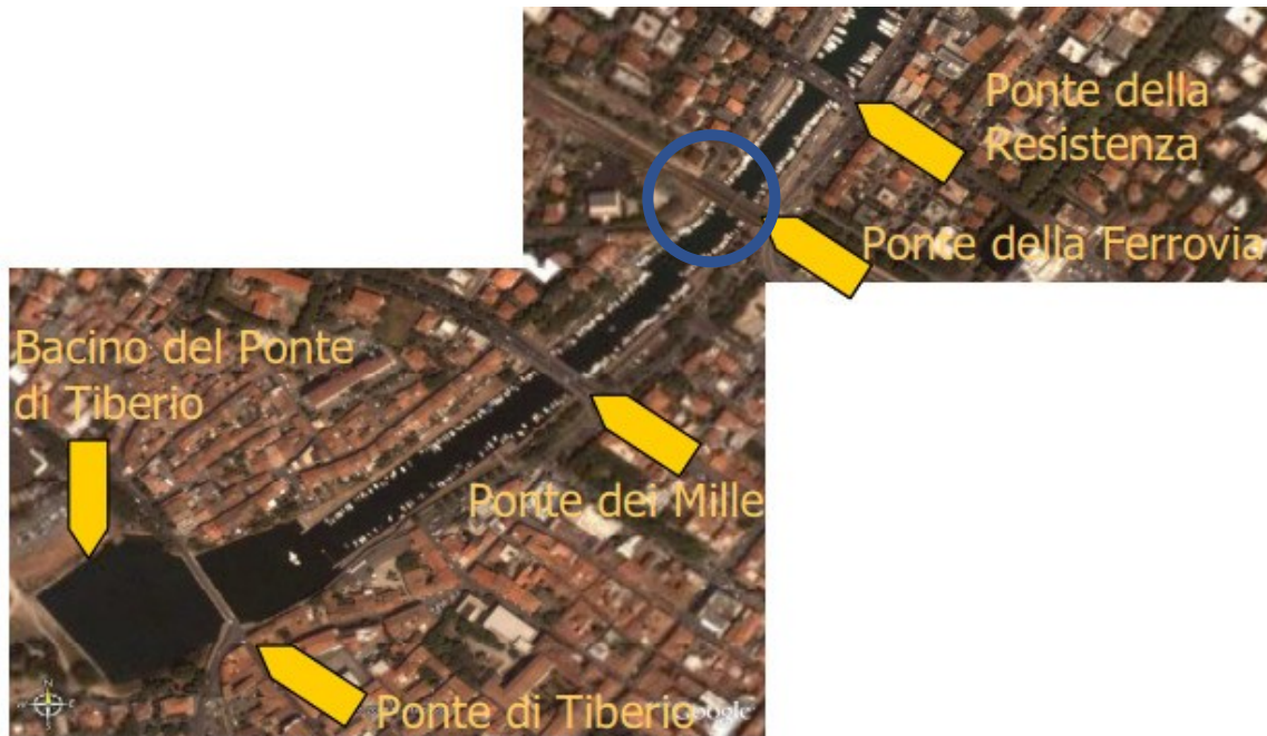
Figura 5. Particolare della foto aerea del Porto Canale dal Bacino del Ponte Tiberio fino al P.te della Resistenza
