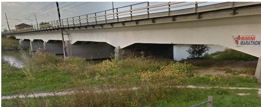
Figura 42. Ripresa fotografica da monte (dall'argine destro) del ponte esistente sul Fiume Marecchia della linea ferroviaria BO-AN, in adiacenza del quale viene realizzato il nuovo ponte della linea tramviaria "TRC2" in progetto
