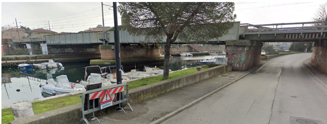
Figura 48. Ripresa fotografica da valle (da sponda sinistra) del ponte esistente sul Porto Canale di Rimini della linea ferroviaria BO-AN, a monte del quale viene realizzato il nuovo ponte della linea tramviaria "TRC2" in progetto
