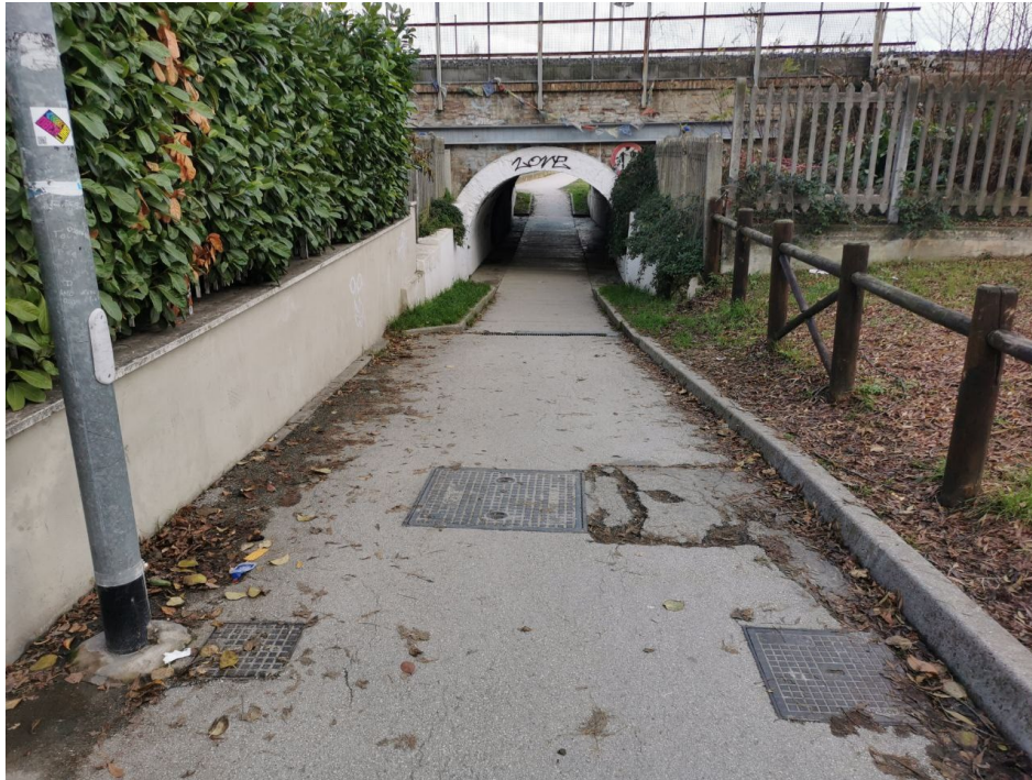
Figura 56. Vista da monte del manufatto di sottopasso dello scolo Dosso sulla linea ferroviaria BO-AN
