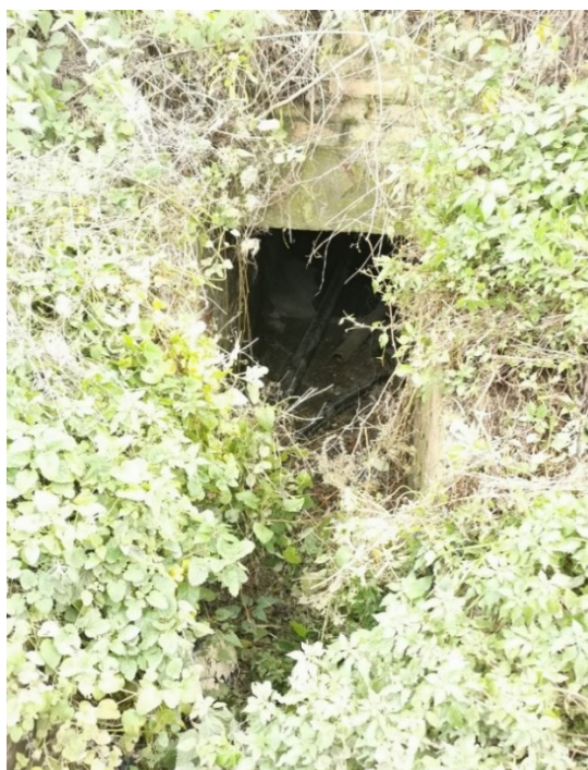
Figura 61. Dettaglio dell'imbocco di valle del sottopasso dello scolo Matrice Spule sulla linea ferroviaria BO-AN
