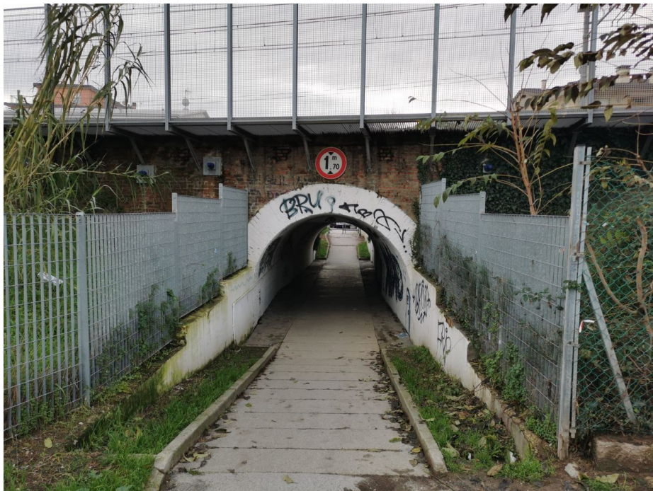
Figura 57. Vista da valle del manufatto di sottopasso dello scolo Dosso sulla linea ferroviaria BO-AN
