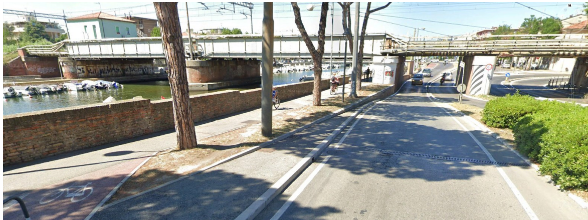
Figura 47. Ripresa fotografica da monte (da sponda destra) del ponte esistente sul Porto Canale di Rimini della linea ferroviaria BO-AN, in adiacenza del quale viene realizzato il nuovo ponte della linea tramviaria "TRC2" in progetto
