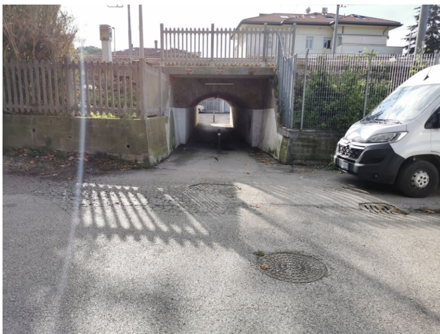
Figura 55. Vista da valle del manufatto di sottopasso dello scolo Dossetto sulla linea ferroviaria BO-AN
