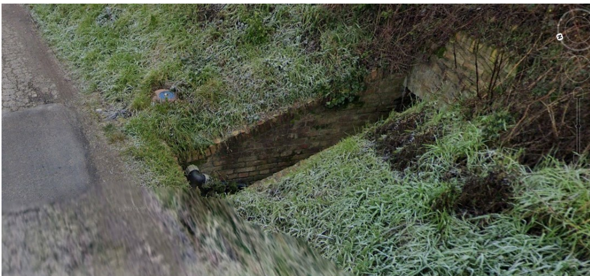
Figura 60. Vista da valle del manufatto di sottopasso dello scolo Matrice Spule sulla linea ferroviaria BO-AN
